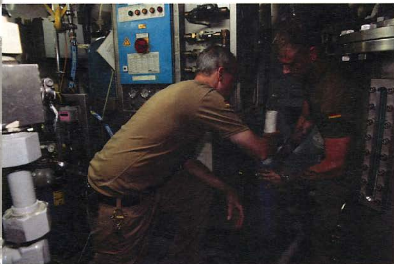
Wartungsarbeiten am Frischwassererzeuger
