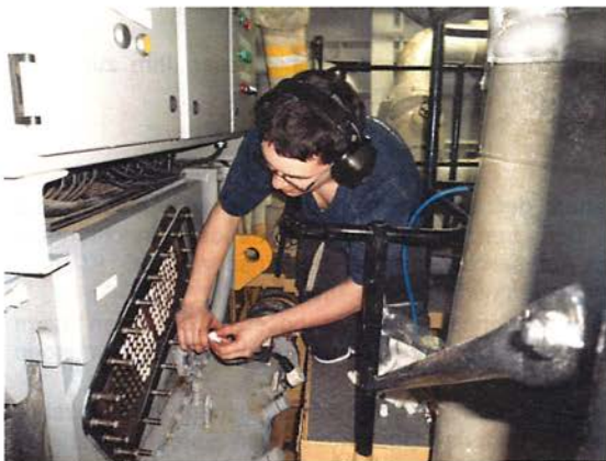
Wartungsarbeiten am Turbokaltwassersatz
