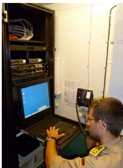
OBtsm Ufken, 2. Elektronikmeister („IT-Meister“), im Serverraum der BAYERN
